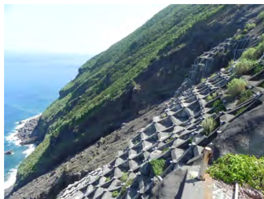
写真 12 大千代港付近の崩壊防止工事
