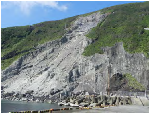
写真 13 三宝港背後の崩壊防止工事
